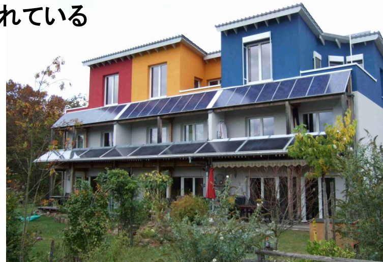
庇に設置した集熱器
