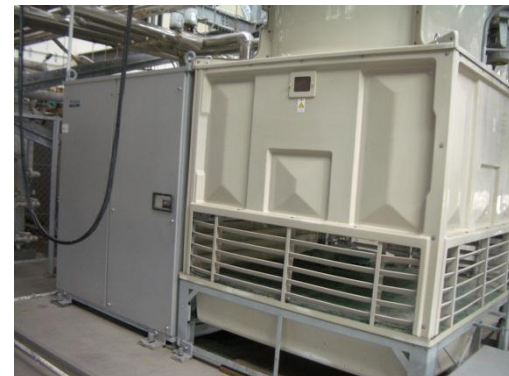
冷却塔一体型温水焚吸収式 冷温水機105.6kW(30RT)
