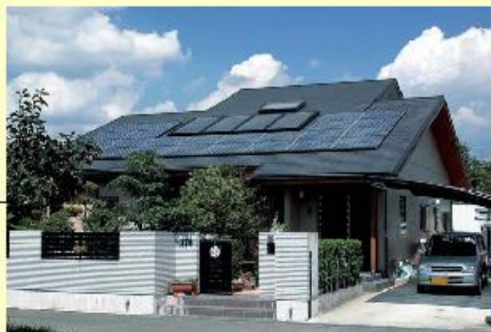
(矢崎総業株式会社提供) 太陽光と太陽熱を利用したハイブリッドシステム
