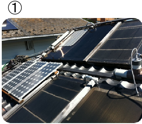
① 太陽電池合体型ヒートル・パネル
