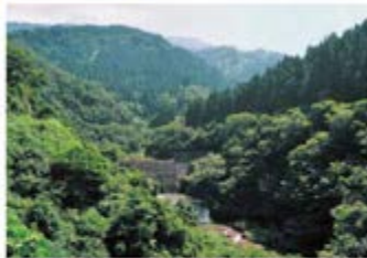
小早月川(発電事業水系)写真中央は砂防ダム
